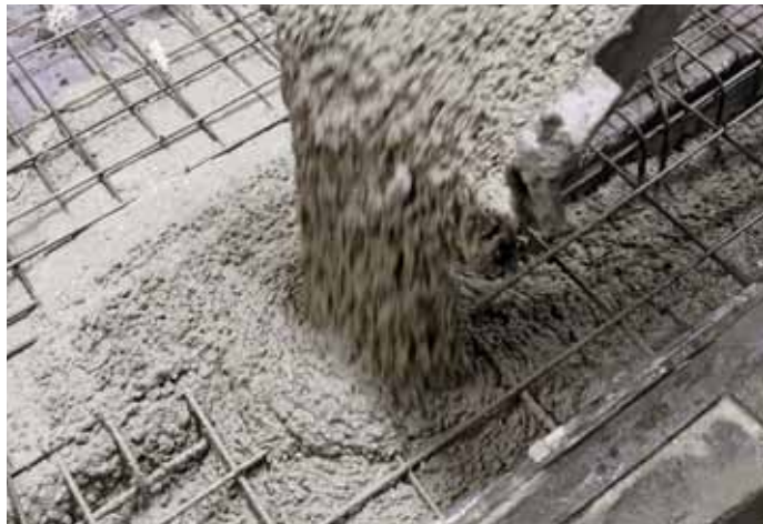
Beton und Stahl ergänzen hervorragend Ihre Eigenschaften. Beton nimmt auftretende Druck- und Stahl Zugkräfte auf.
