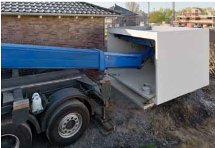
Zuerst wird der Garagenanbau mit modernsten Spezialfahrzeugen geliefert und montiert.
