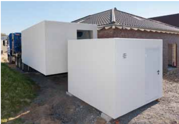
Die Garage wird vor dem Anbau abgesetzt.
