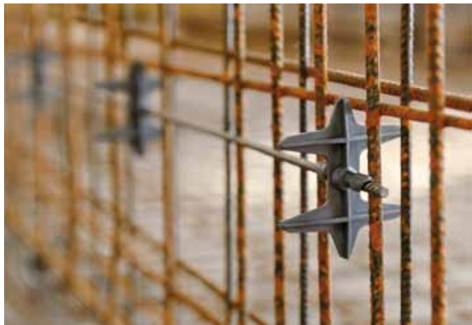
Die Bewehrung erfolgt aus speziellen Baustahlmatten und Stabstahl.
